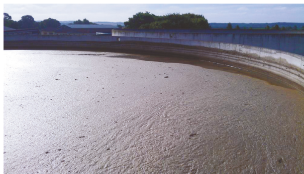
Foto 2: Bildandet av svämtäcke efter 24 timmar och användning av tillsatsen Active NS i biogasanläggningens 2 800 m 3 lagertank efter en timmes noggrann blandning med hjälp av en kraftuttagsdriven omrörare för representativ provtagning.
