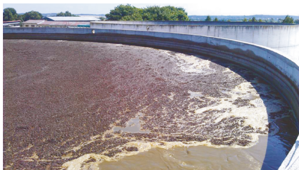
Foto 1: Bildandet av svämtäcke på biogasanläggningens 2 800 m 3 lagertank efter en timmes noggrann blandning med hjälp av en kraftuttagsdriven omrörare för representativ provtagning av kontrollen utan tillsättning av tillsats.
